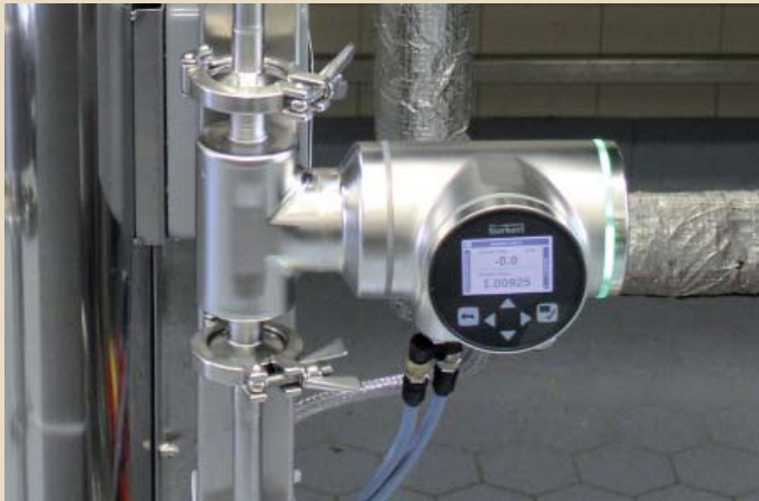
Abb. 4 Durchflussmessung der Läuter- und Ausschlagwürze funktioniert nach patentiertem SAW-Verfahren
