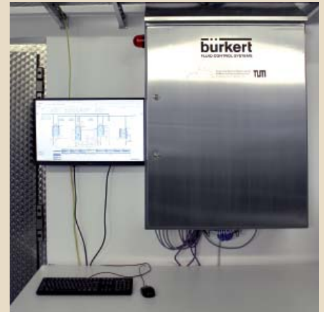
Abb. 5 Ventilinsel im Edelstahlschaltschrank (Hygienic Design) steuert alle im Prozess verbauten Ventile an Quelle: Bürkert/BLQ
